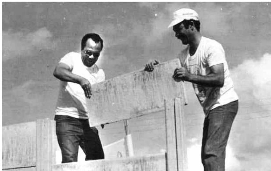
JAF em mutirão de construção de casas.
